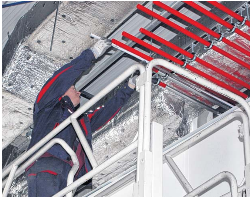
Toralf Steinfurth von der Rostocker Firma Isenthal beim Rohrleitungsbau im neuen Produktionsgebäude von MTN Neubrandenburg.
